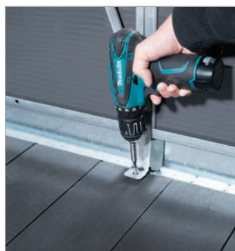
Horganyzott acél talapzat
