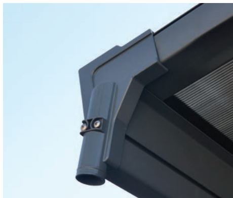
Minden sarkában beépített vízelvezető csatorna van.
