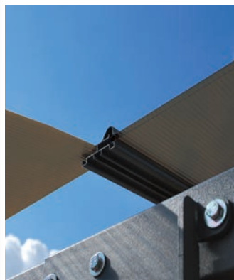
Egyszerű tetőpanel rögzítés
